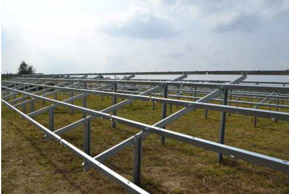
Zdjęcie nr 2- Zdjęcie z realizacji farmy fotowoltaicznej o mocy 1,504 MWp koło Gubina
