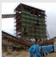
Montaż obudowy przesiewacza
