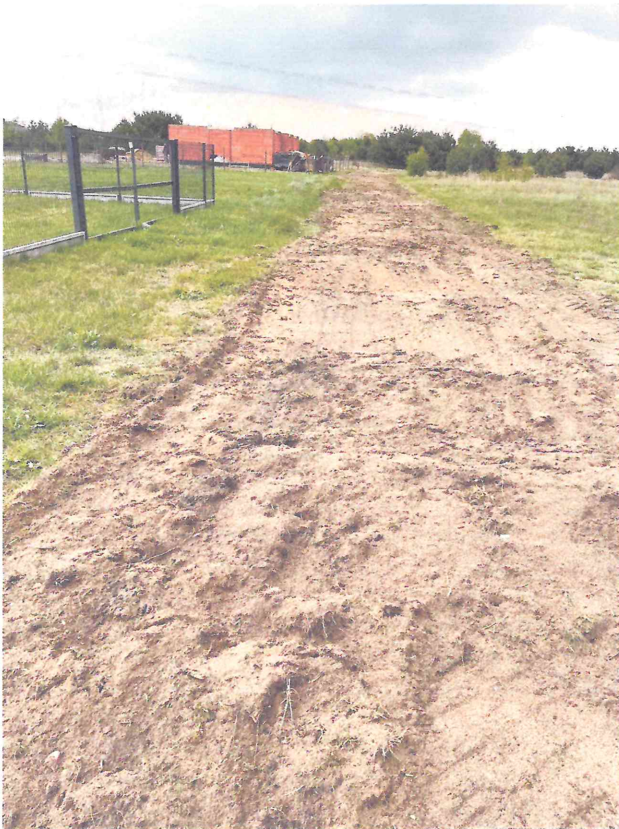
Załącznik nr 2. Zdjęcia ukazujące stan omawianej drogi
