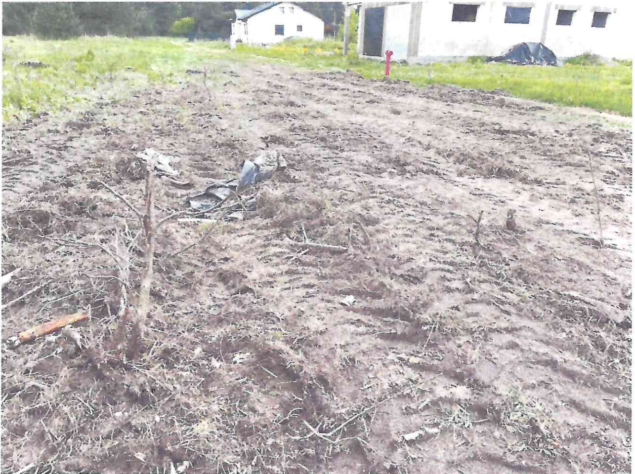
Załącznik nr 4. Zdjęcia ukazujące stan omawianej drogi
