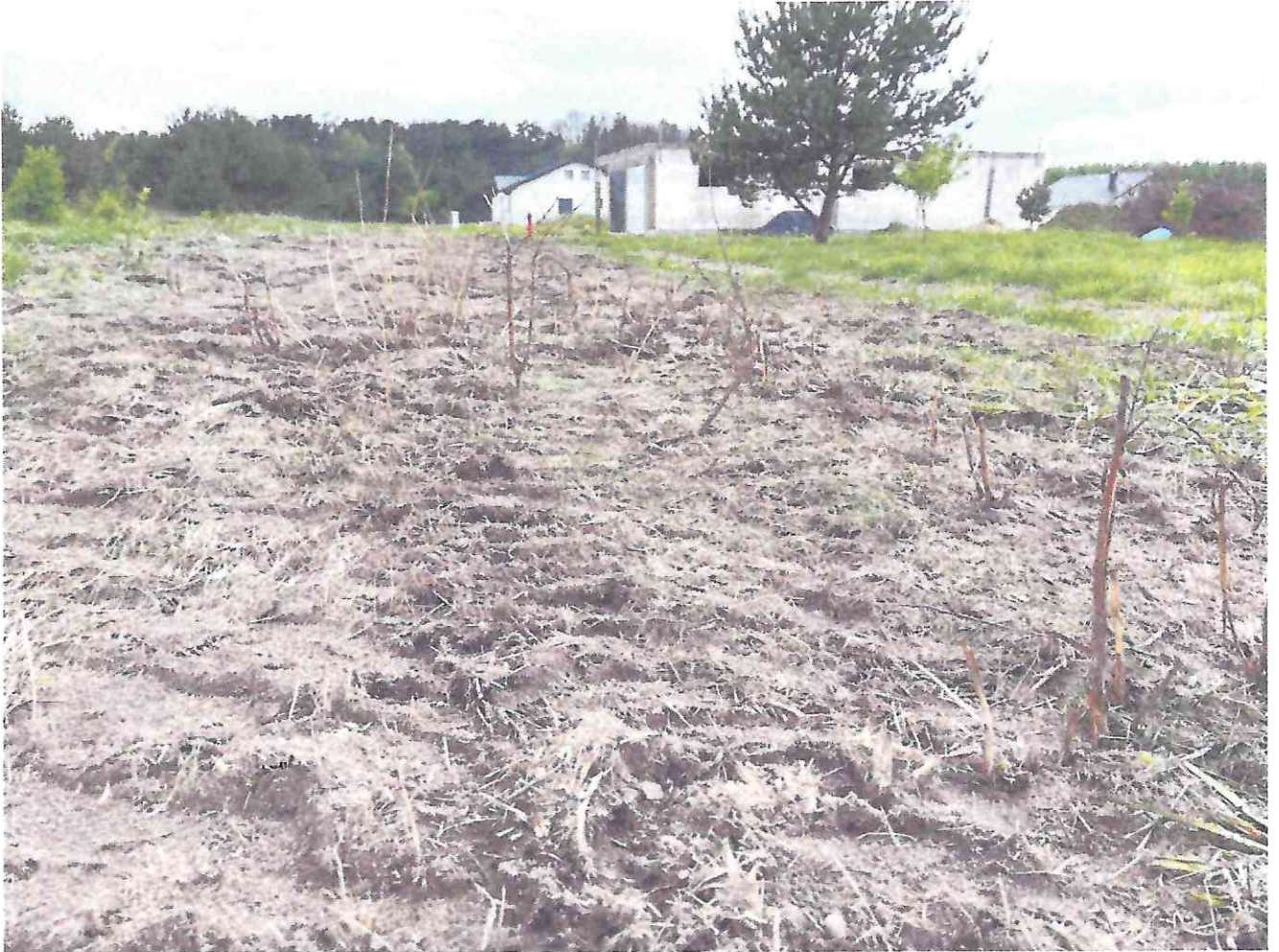
Załącznik nr 5. Zdjęcia ukazujące stan omawianej drogi
